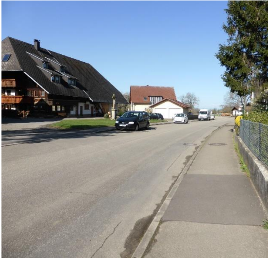
Die Bundesstraße Blickrichtung Westen (links im Bild der Pfändlerhof)
