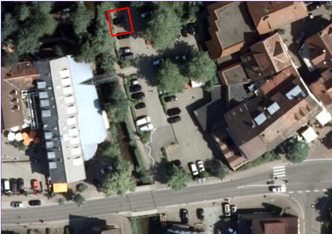
Abbildung 62: Parkplatz Freiburger Straße. Quelle: Luftbilder der Gemeinde Kirchzarten.
