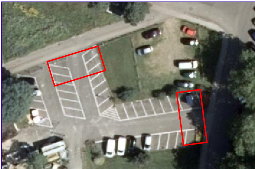
Abbildung 63: Parkplatz Black Forest Studios. Quelle: Luftbilder der Gemeinde Kirchzarten.
